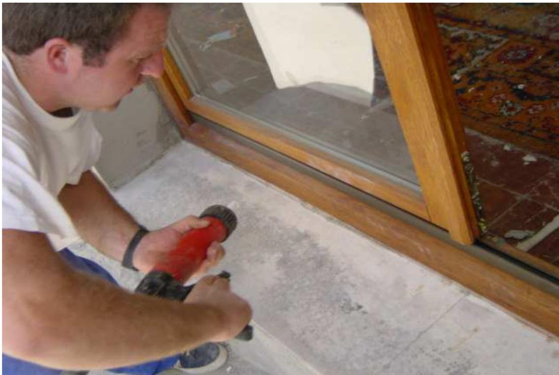
La instalación de la carpintería exterior se puede realizar sobre un precerco, o a muro directo y siempre con anclajes de patillas, tacos o grapas, que permitan sujetar firmemente los marcos. Imprescindible aplicar posteriormente sellado de espuma de poliuretano aislante en todo el perímetro, así como silicona neutra impermeable por el exterior en la junta entre el marco y la guarnición por todo su contorno.
